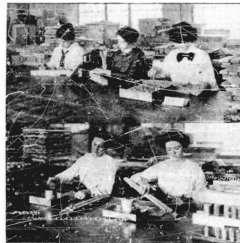
9. Постановка пробокъ въ указанныя доски. 10. Покрѣпленіе пробокъ слоемъ парафиннаго воска.
