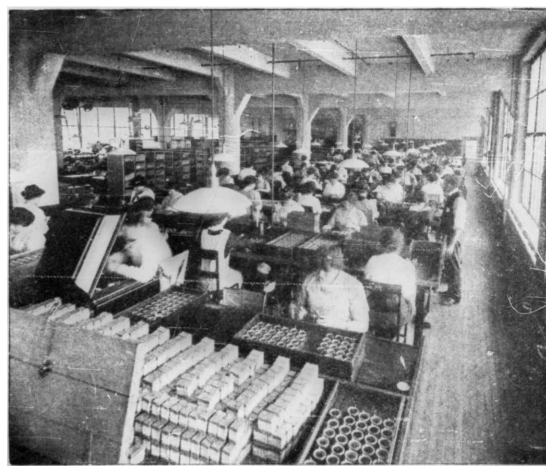
34. Общий видъ в сборку мембранъ. Контроль (проба) мембранъ и сборка регуляторовъ и тонармовъ.
