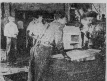
Окраска большихъ корпусовъ аппаратомъ.
